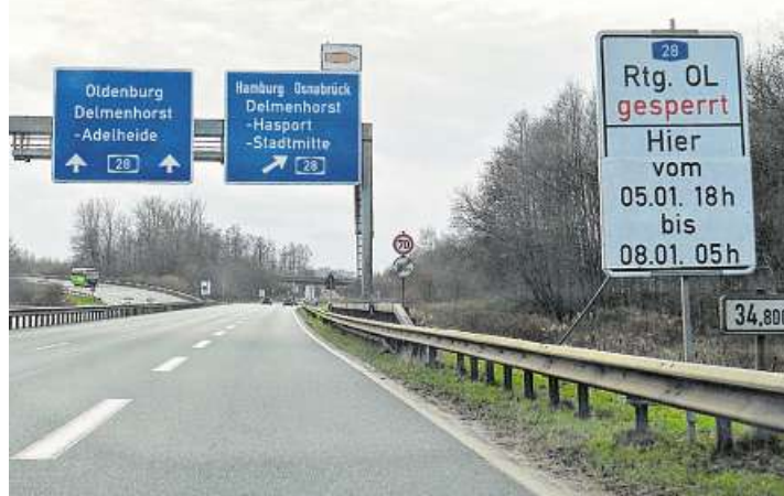
Die Bundesstraße B75 wird im Bereich des Autobahndreiecks Delmenhorst am kommenden Wochenende in Richtung Oldenburg gesperrt sein.
